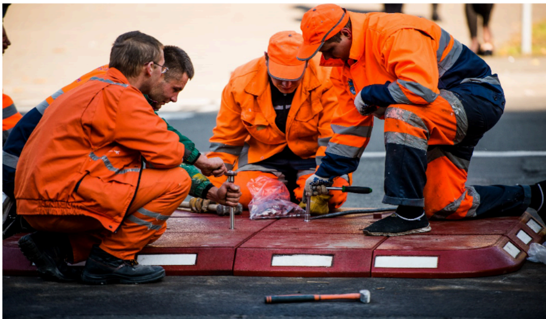
Рис. 3. Демонтаж острівця безпеки, вул. Архипенка, м. Київ
