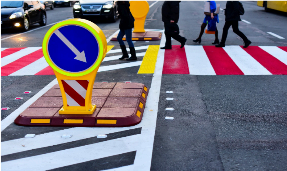
Рис. 4. Модульний острівець безпеки, вул. Архипенка, м. Київ
