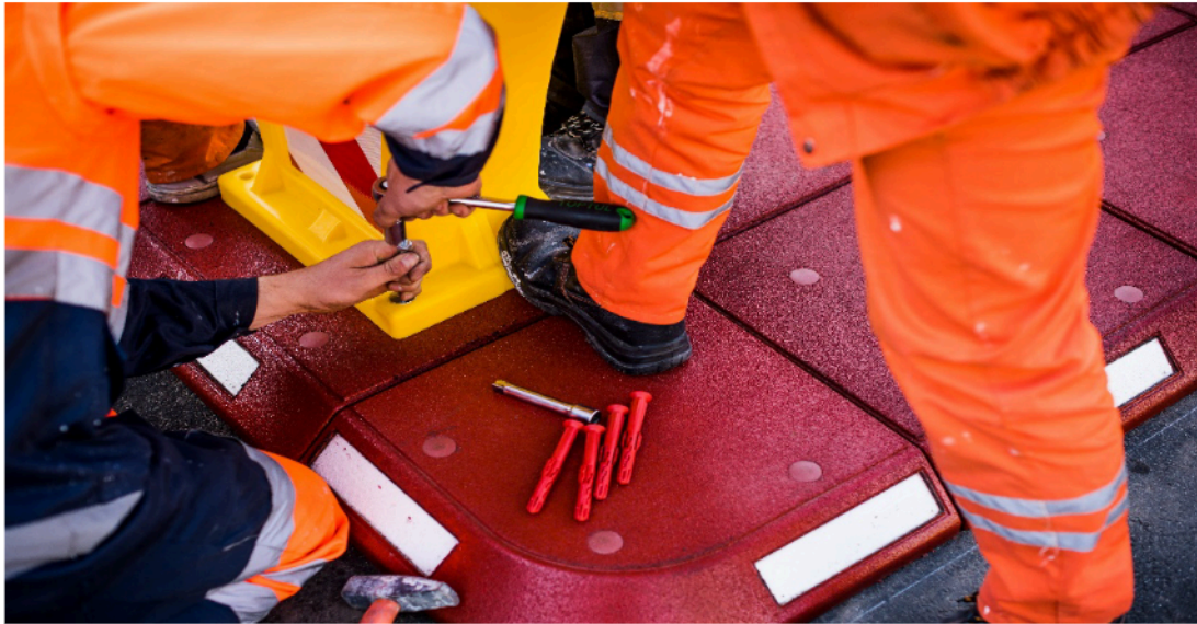
Рис. 2. Встановлення елементів модульного острівця безпеки
